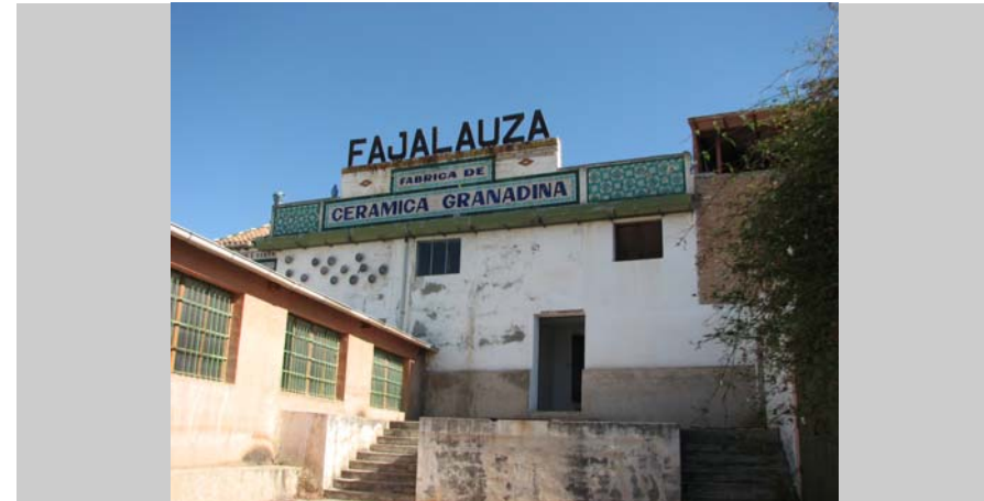
3 Fachada patio de entrada
