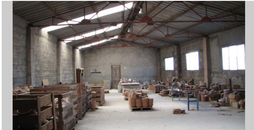
16 Nave de cocción (ampliación años 80)
